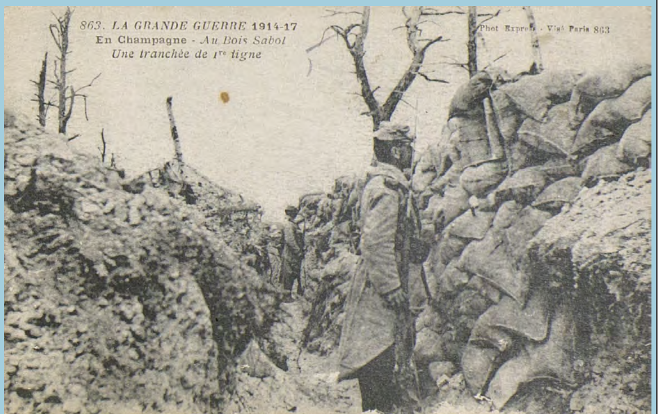
Une tranchée de première ligne — Au Bois Sabot — Archives départementales du Lot-et-Garonne, 25Fi466
